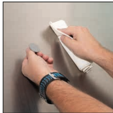
2. Puhdista ja karhenna kiinnike sekä asennuspinta.
